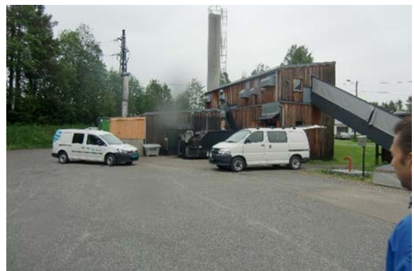
Biobrenselanlegget på tomten
