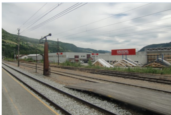
GL's anlegg med lagrede takstoler sett fra Ringebu stasjon
