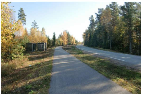
Gaustadvegen med gang- og sykkelveg. Trafoene ved Hydro ses i forgrunnen.
