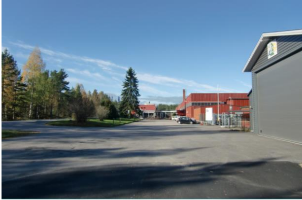
Hydro med sin søndre avkjøring. Varmesentralen ses i forgrunnen.
